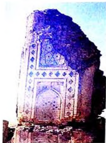
1948-ci ildə baş vermiş 9 ballıq zəlzələdən sonra Aşağıda şəhərin yaxınlığındakı Annuu məscidinin dağıntıları. Keçmiş portalm əsasında olan horizontal yaxıq güclü horizontal impulsdan şəhər verir.
