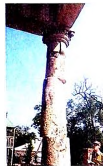
1927-ci ildə baş vermiş 7 ballıq zəlzələ zamanı. On İki Ağostol (Balaklava) kilsəsinin sütununda baş verən yerdəyişmə.
